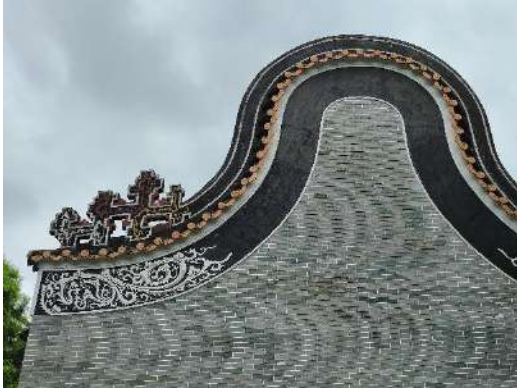
图 1-2：沙湾古镇大巷涌路某民居
